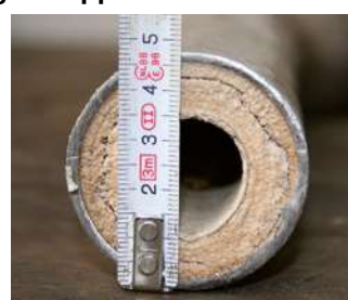
Vakuum-WC tube before
